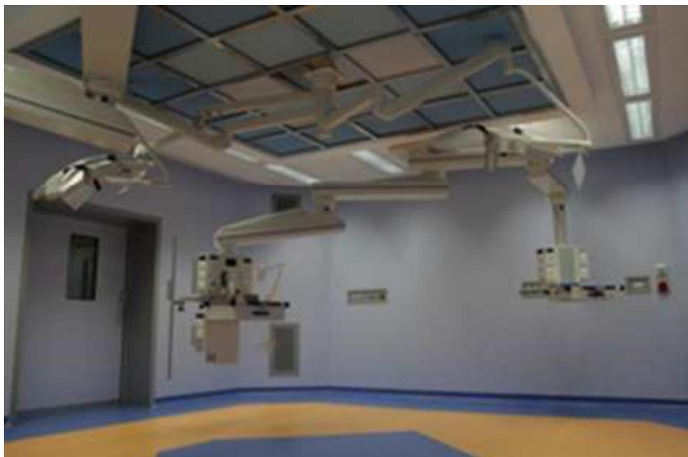
Основой для подачи стерильного воздуха в помещение является «Ламинарный потолок», устанавливаемый автономно или вместе с системой вентиляции и кондиционирования воздуха. Прошедший через Ламинарный потолок воздух обеззараживается, приобретает бактерицидные свойства и подается в зону работы хирургической бригады абсолютно стерильным направленным ламинарным потоком с оптимально комфортными тепло-влажностными параметрами.
