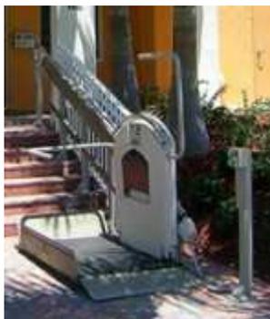
Хpress II наклонный подъем платформы инвалидной коляски является идеальным решением для прямых лестниц с двумя посадками. Он может быть установлен на любой стороне лестницы, в зависимости от конструкции лестницы и местоположения. Эти лифты инвалидного кресла также могут быть установлены практически без структурных изменений.
