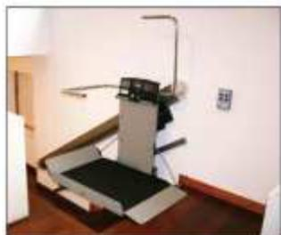
Х3 наклонный подъемник инвалидной коляски является идеальным решением для прямых лестниц внутри жилых домов и общественных помещениях. Х3 подъемник инвалидной коляски питается от аккумуляторных батарей. Батареи заряжаются, когда лифт не используется. Элементы управления панели вызывной станции являются беспроводными, что делает установку Х3 проще, чем проводные традиционные лифты инвалидного кресла. Нет необходимости устанавливать неприглядный канал сетевого питания на стенах.
